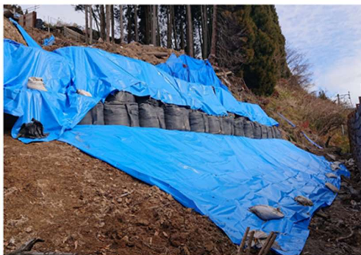
<大型土のう設置>
