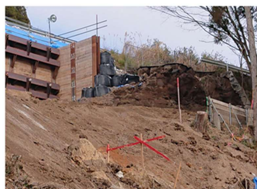
<ブロック積撤去>
